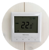
Sähkölattialämmitys WiFi-kaukosäätimellä
